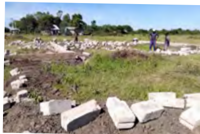
Die Bauarbeiten gehen voran
